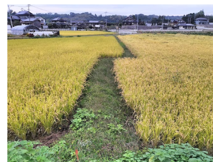
10 年前の熊本地震によってクランク状になった畦道（益城町大字堂園）
